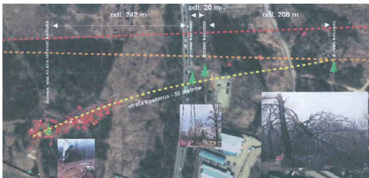
Rys. 9. Miejsce zdarzenia z zaznaczonymi charakterystycznymi wymiarami 39
