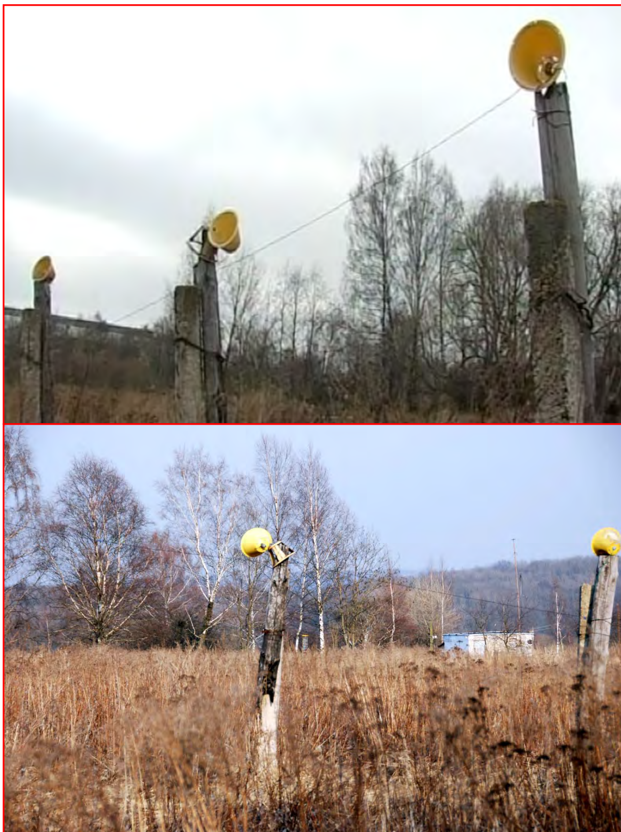
Fot. 22. Stan techniczny świateł podejścia
